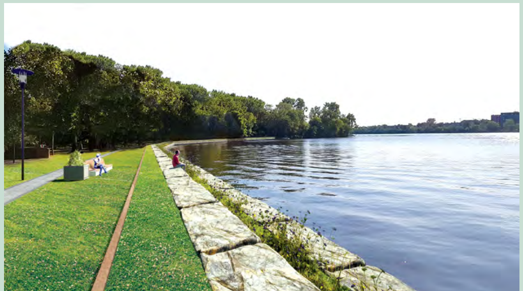
Le nouvel enrochement prévoit un aménagement en palier au parc Louis-Hébert favorisant l'accès à l'eau. Photo : Courtoisie Hydro-Québec.
