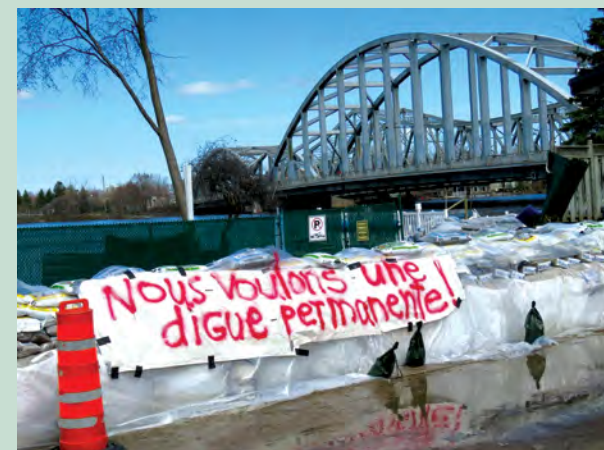
Les inondations successives ont convaincu l'arrondissement de réaliser une digue permanente pour protéger les rues des crues de la rivière des Prairies. Photo : JDV / archives.
